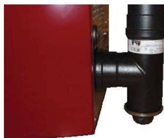
Fig. 127 - Nettoyage du conduit de fumée
