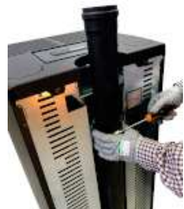
Fig. 84 - Conduit arrière d'évacuation des fumées monté
