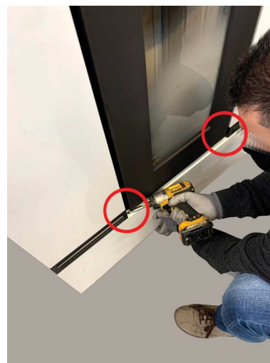
Fig. 56 - Fixer le panneau inférieur
