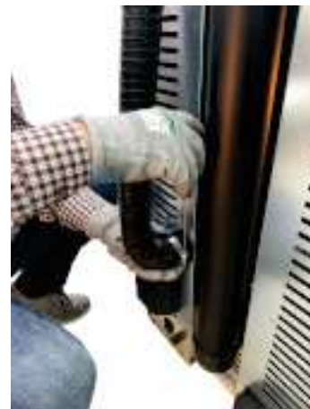
Fig. 87 - Raccorder le tuyau de l'air comburant
