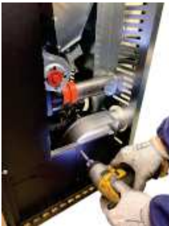
Fig. 92 - Positionnement des tuyaux pour la canalisation
