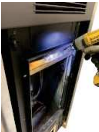
Fig. 128 - Retirer le déflecteur
