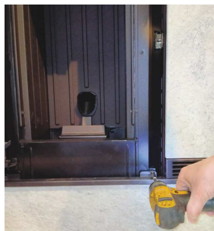
Fig. 76 - Visser sur les ailettes
