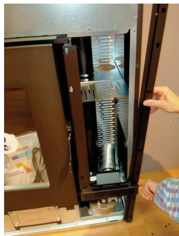
Fig. 67 - Insérer le montant
