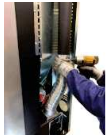
Fig. 96 - Fixer les tuyaux
