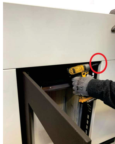
Fig. 53 - Fixer le panneau supérieur
