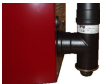
Fig. 34 - Nettoyage du conduit de fumée
