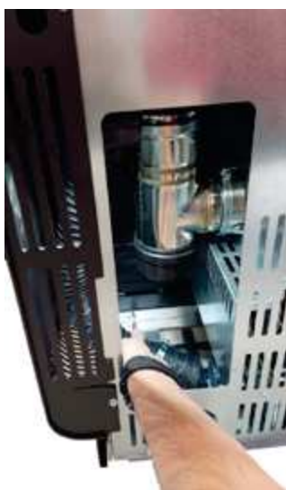
Fig. 57 - Insérez le tuyau flexible
