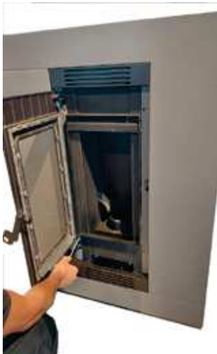
Fig. 28 - Retirer les vis
