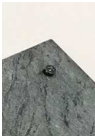
Fig. 31 - La vis doit dépasser
