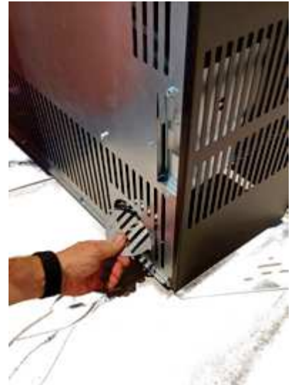
Fig. 49 - Passage du tuyau
