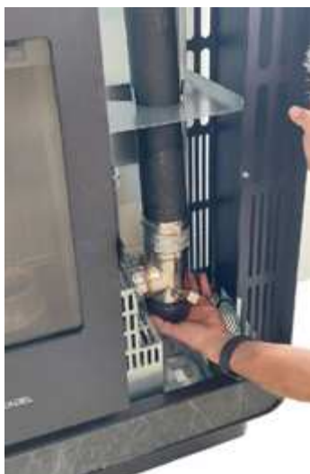
Fig. 74 - Nettoyage du conduit de fumée
