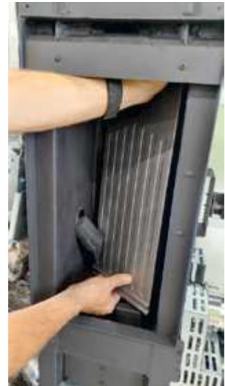
Fig. 77 - Retirer l'arrière du foyer 2
