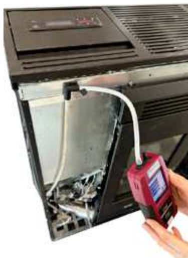
Fig. 66 - Connexion du pressostat numérique
