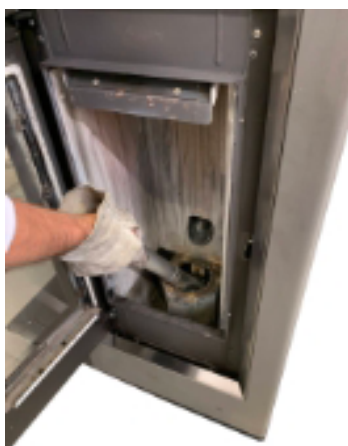
Fig. 33 - Nettoyage l'espace du brasero
