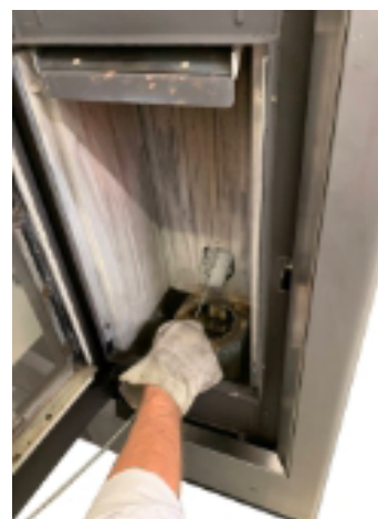
Fig. 34 - Nettoyage avec nettoie-pipes
