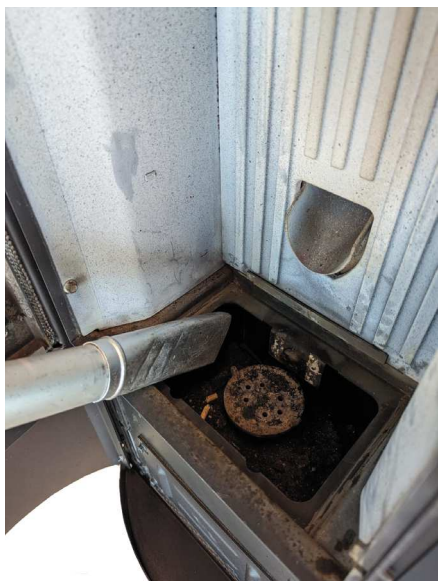
Fig. 40 - Nettoyage l'espace du brasero
