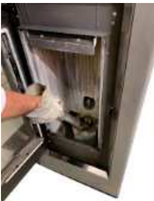
Fig. 36 - Nettoyage l'espace du brasero
