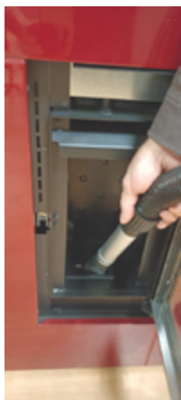
Fig. 34 - Nettoyage l'espace du brasero
