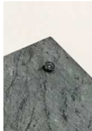
Fig. 46 - La vis doit dépasser
