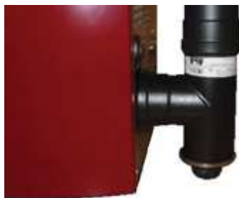
Fig. 96 - Nettoyage du conduit de fumée
