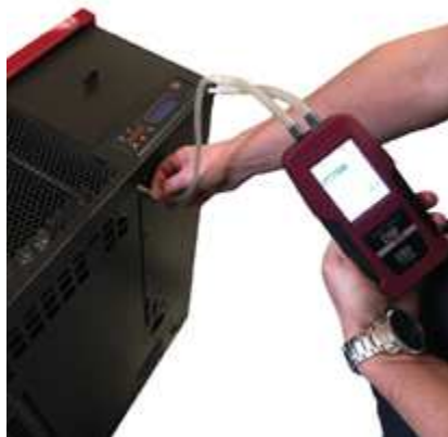
Fig. 95 - Raccordement du pressostat numérique
