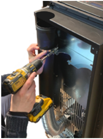
Fig. 78 - Fixer le tuyau d.80 mm
