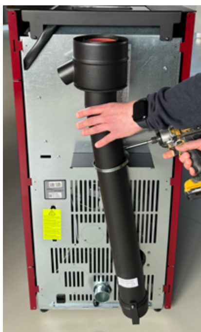
Fig. 66 - Raccorder le tuyau d.80 mm
