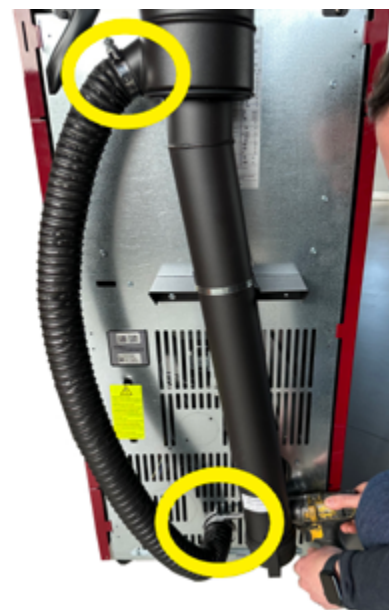
Fig. 67 - Bloquer avec un collier de serrage
