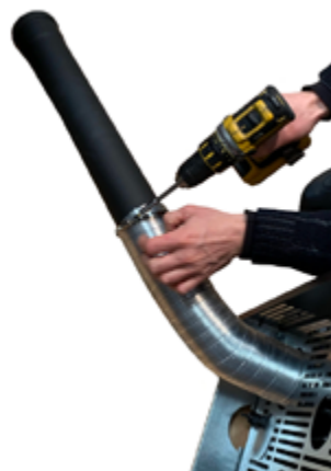
Fig. 76 - Raccorder le tuyau d.80 mm
