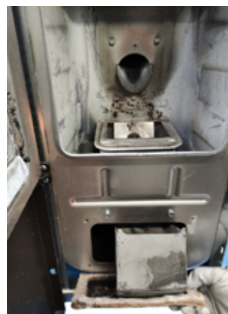
Fig. 90 - Retirer le bouchon d'inspection
