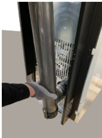
Fig. 56 - Raccorder le tuyau d.80 mm
