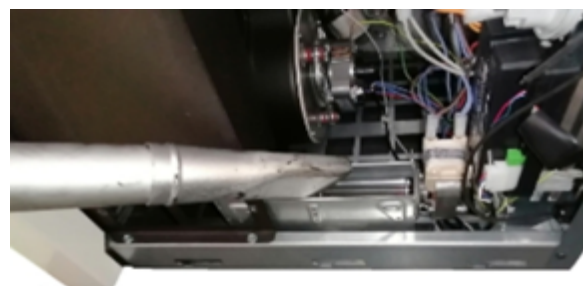
Fig. 96 - Nettoyage de le ventilateur ambiant
