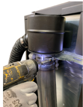
Fig. 57 - Bloquer avec un collier de serrage
