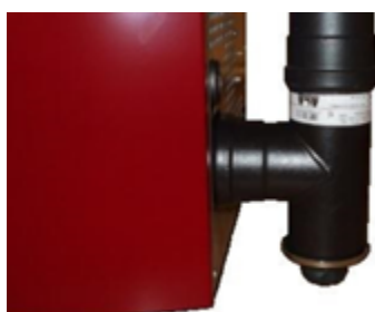
Fig. 88 - Nettoyage du conduit de fumée
