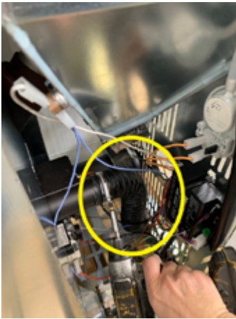
Fig. 52 - Retirer le tuyau flexible
