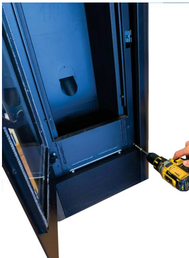
Fig. 46 - Retirer les vis
