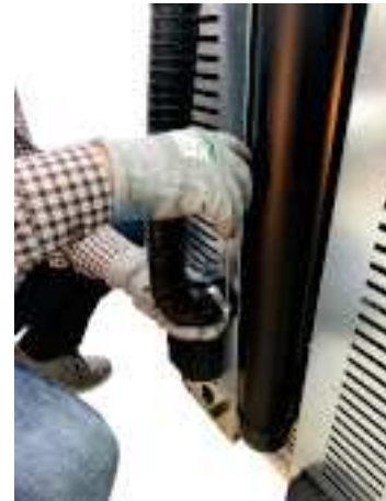
Fig. 71 - Raccorder le tuyau de l'air comburant
