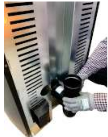
Fig. 63 - Raccorder le raccord en T
