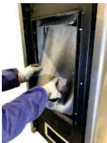
Fig. 101 - Retirer le panneau arrière du foyer
