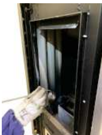
Fig. 103 - Nettoyer avec un goupillon
