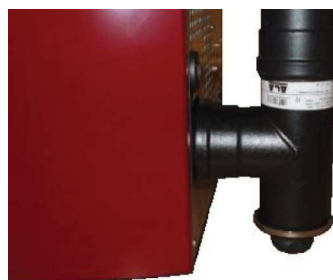
Fig. 97 - Nettoyage du conduit de fumée
