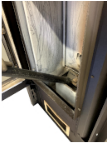
Fig. 35 - Nettoyage l'espace du brasero
