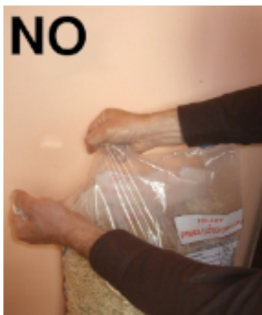
Fig. 24 - Ouverture incorrecte du sac des granulés
