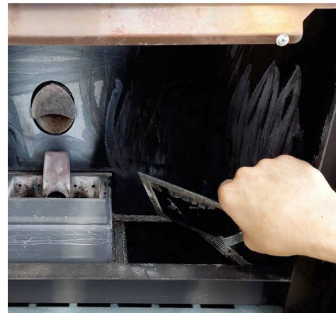
Fig. 112 - Retirer le bouchon d'inspection
