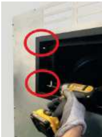
Fig. 79 - Fixation externe de la trappe
