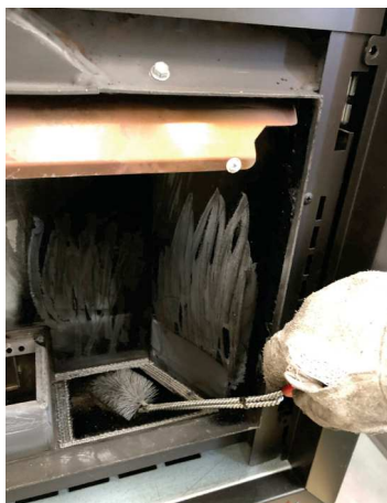
Fig. 113 - Nettoyer avec un goupillon.
