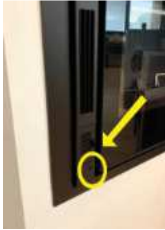
Fig. 38 - Sonde de thermostat
