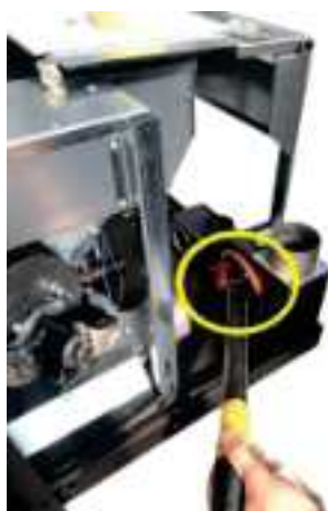
Fig. 124 - Nettoyage du conduit d'évacuation des fumées
