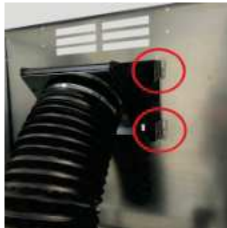
Fig. 80 - Fixation interne de la trappe
