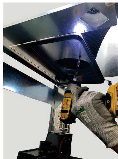
Fig. 78 - Fixation du tuyau flexible
