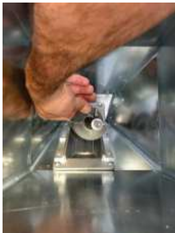
Fig. 103 - Retrait des spirales
