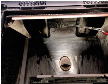
Fig. 115 - Nettoyer avec un goupillon.
