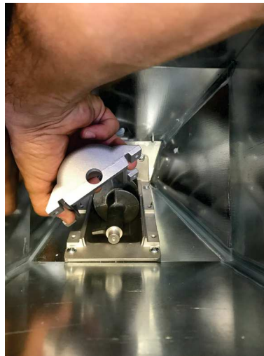
Fig. 101 - Retrait de la coque
