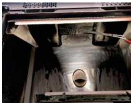
Fig. 78 - Nettoyer avec un goupillon.
