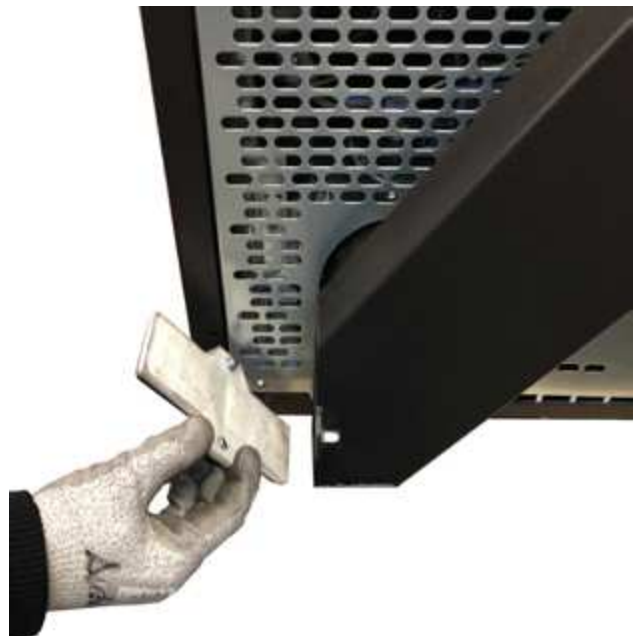
Fig. 73 - Nettoyage du conduit de fumée
