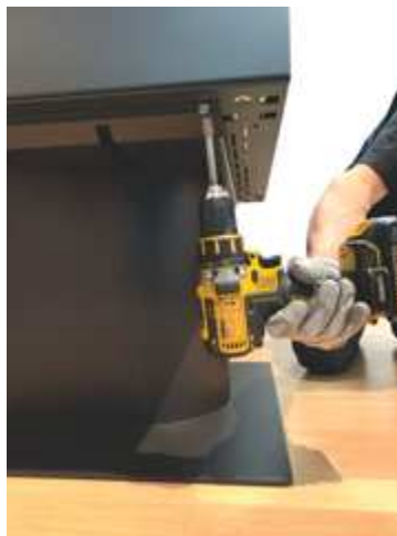
Fig. 25 - Fixation du socle
