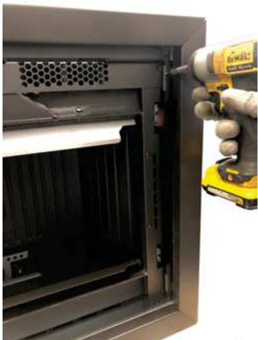
Fig. 31 - Retirer les vis
