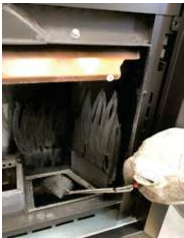
Fig. 76 - Nettoyer avec un goupillon.
