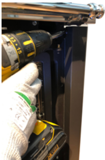
Fig. 40 - Accrocher les parois sur 2 vis
