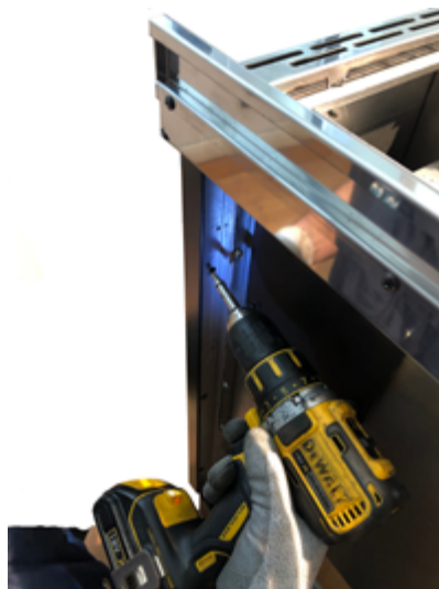
Fig. 41 - Fixer les parois sur 3 vis
