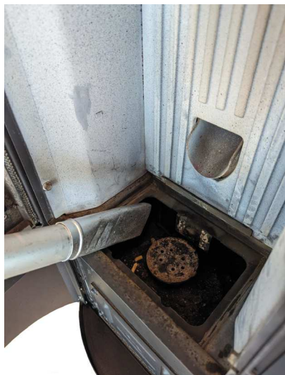
Fig. 43 - Nettoyage l'espace du brasero
