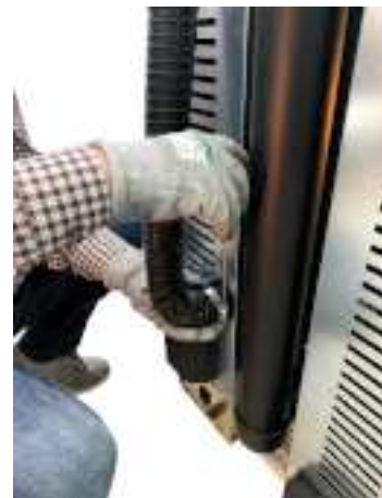
Fig. 50 - Raccorder le tuyau de l'air comburant
