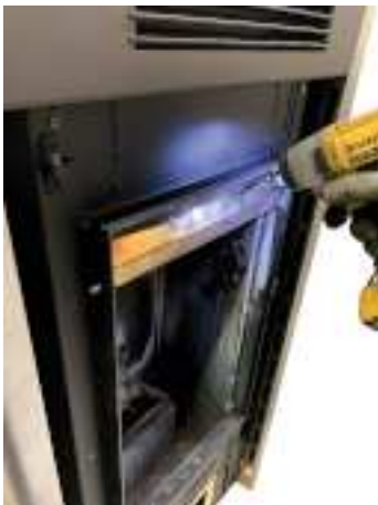
Fig. 78 - Retirer le déflecteur
