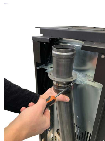
Fig. 47 - Raccorder le tuyau de l'air comburant
