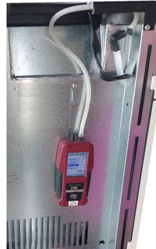
Fig. 69 - Raccordement au pressostat numérique
