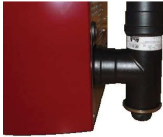
Fig. 77 - Nettoyage du conduit de fumée
