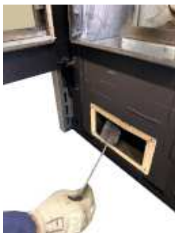
Fig. 75 - Nettoyer avec un goupillon
