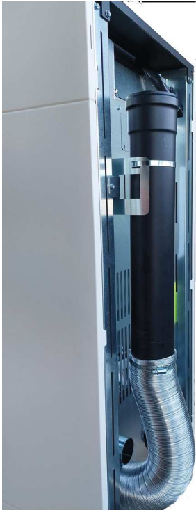
Fig. 62 - Fixer le tuyau d.80 mm
