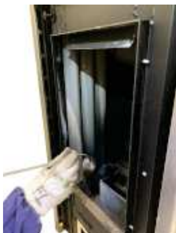
Fig. 84 - Nettoyer avec un goupillon
