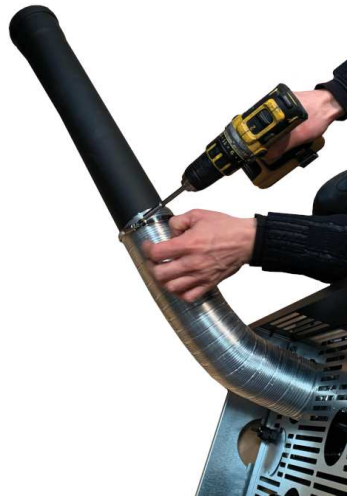
Fig. 60 - Raccorder le tuyau d.80 mm
