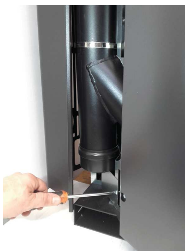
Fig. 86 - Dévisser le dispositif de blocage du bouchon
