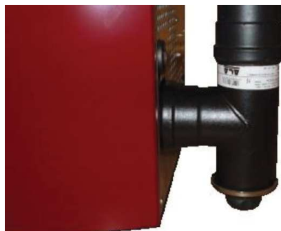
Fig. 84 - Nettoyage du conduit de fumée
