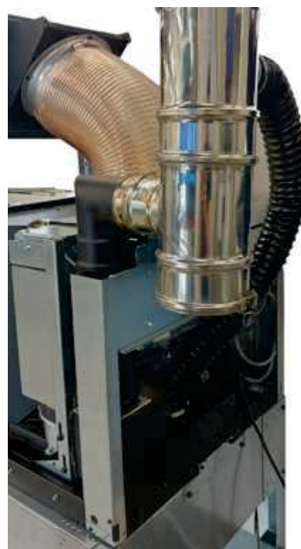
Fig. 89 - Raccordement du tuyau concentrique + raccord de l'air
