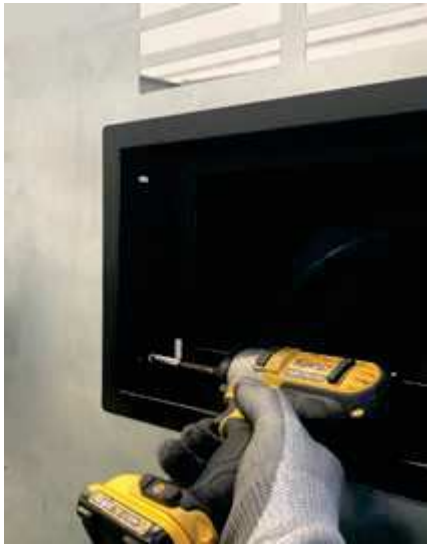
Fig. 79 - Fixation externe de la trappe
