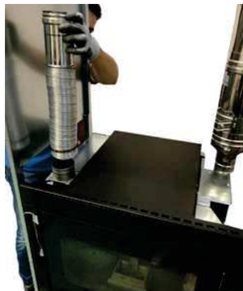
Fig. 72 - Insertion de l'insert
