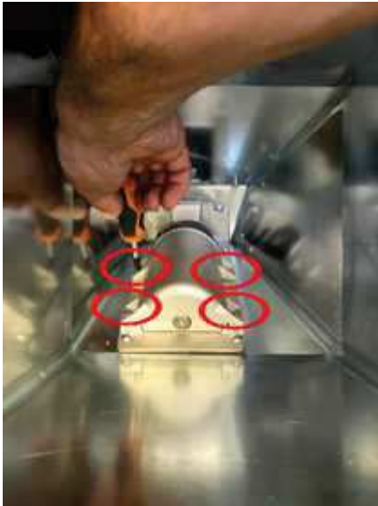
Fig. 96 - Retrait des vis
