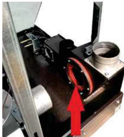
Fig. 120 - Nettoyage du conduit d'évacuation des fumées
