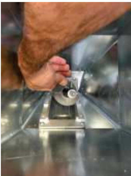
Fig. 99 - Retrait des spirales
